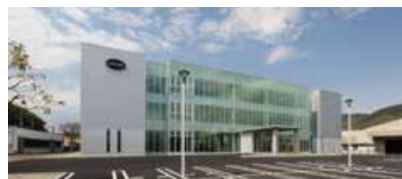
▲本社ビル 2017年4月竣工
