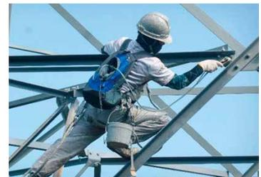
▲18万7千ボルト送電鉄塔での塗装の様子
