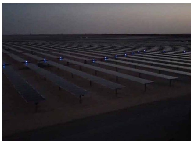
発電所では、同社が手がけた61台の清掃ロボットが1台につき夜間の8時間、毎日稼働。運用開始から3年が経過し、稼働時間は1台あたり4000時間を超えた
