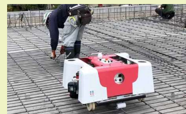
▲鉄筋結束ロボット「トモロボ」
