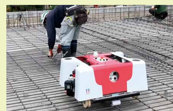
▲鉄筋結束ロボット「トモロボ」
