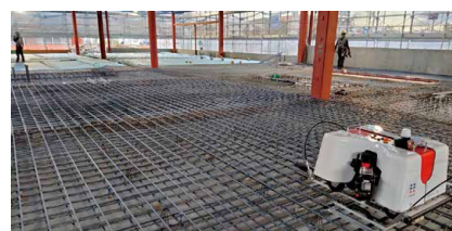
▲建設現場で実際に稼働する「鉄筋結束トモロボ」
